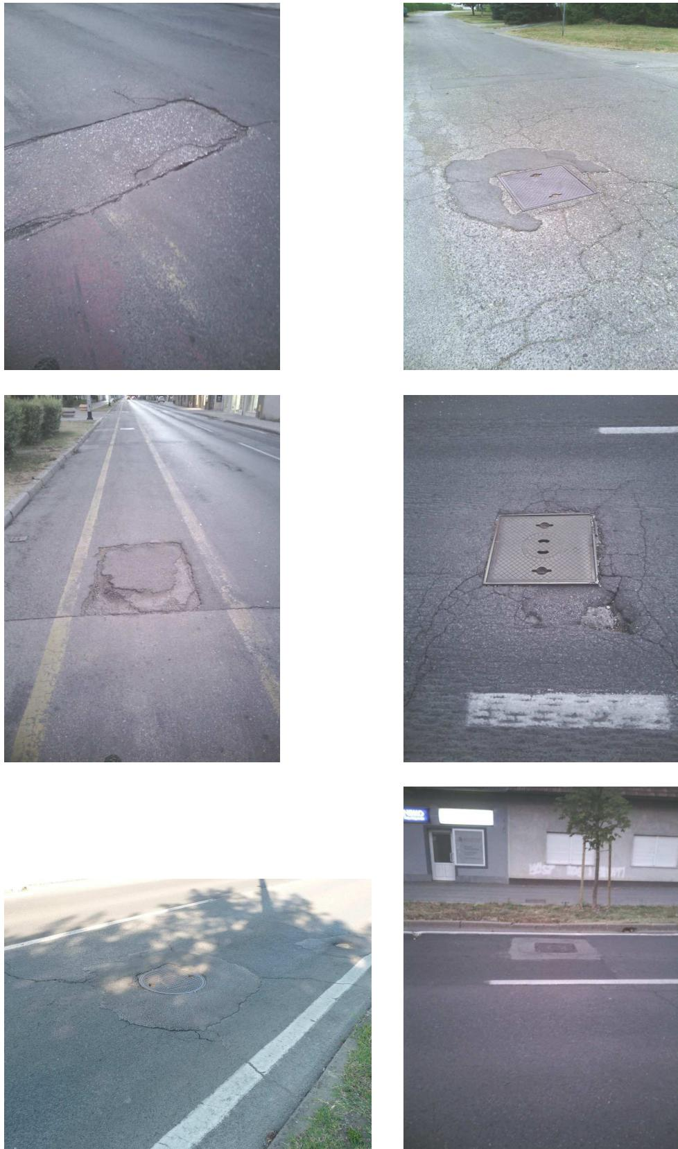
Slika 4. Primjeri loše izvedenih sanacija okana komunalnih instalacija: - nastavak
