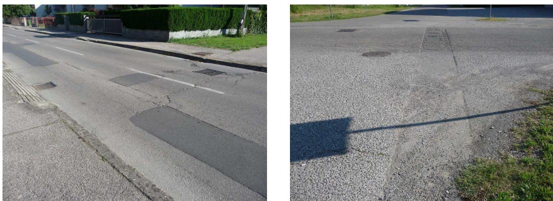
Slika 5. Primjeri dobro izvedenih sanacija okana komunalnih instalacija
