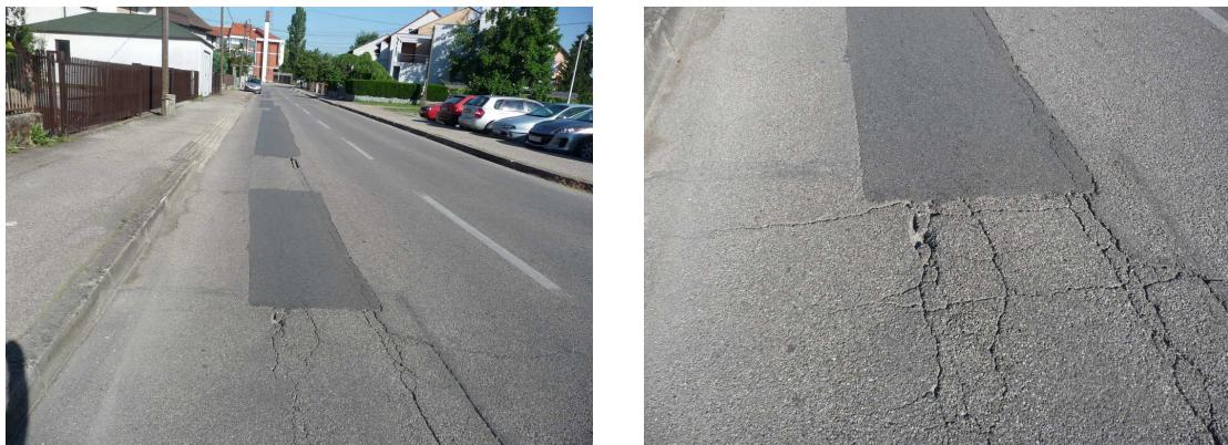
Slika 6. Oštećenje kolnika uslijed nejednolikog slijeganja
