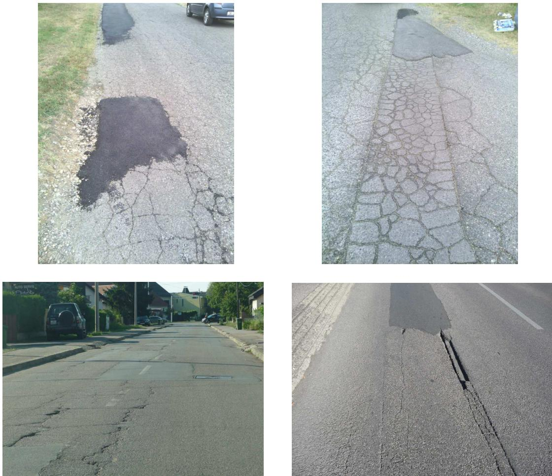
Slika 3. Primjeri loše izvedenih sanacija rovova - nastavak
