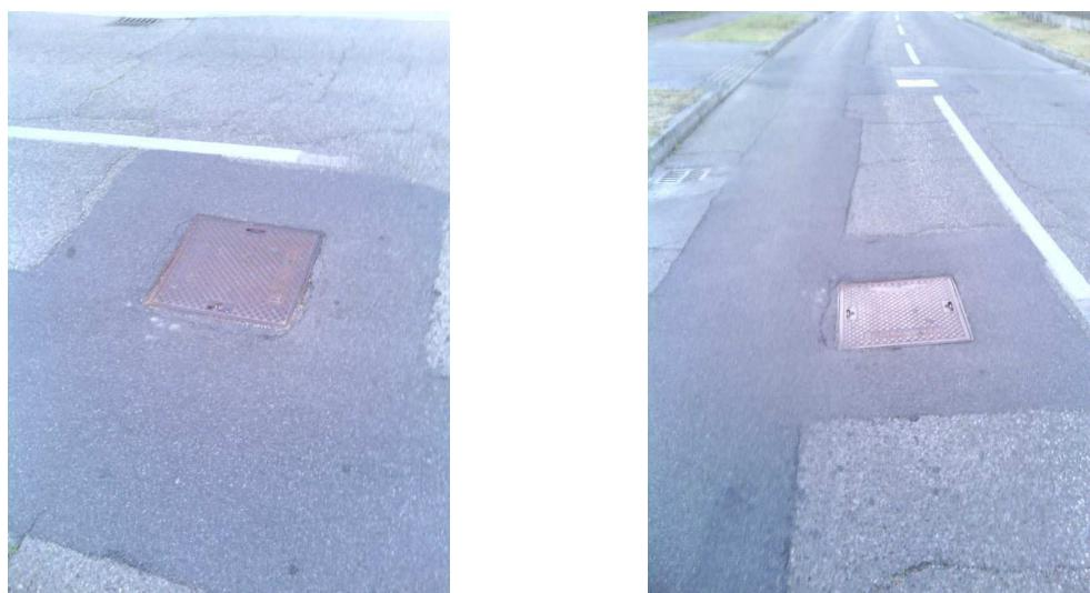
Slika 4. Primjeri loše izvedenih sanacija okana komunalnih instalacija:
